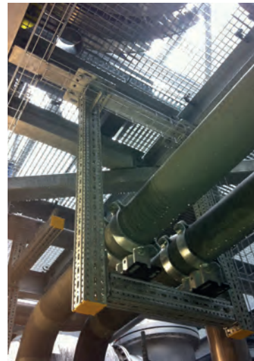
Archivfoto: Modulares Schraubsystem siFramo zur schnellen Montage von Sekundärstahlbau
