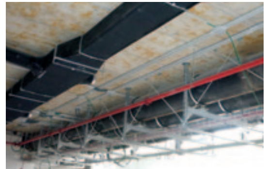
Erdbebensichere Befestigungen sind wesentlich steifer in horizontaler Richtung auszuführen und/oder zu verstreben.
