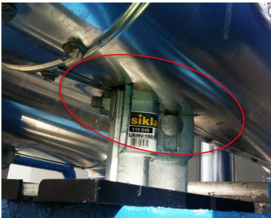
Sikla Isolierschablone für LA- und LC (LD)- Rohrlager
