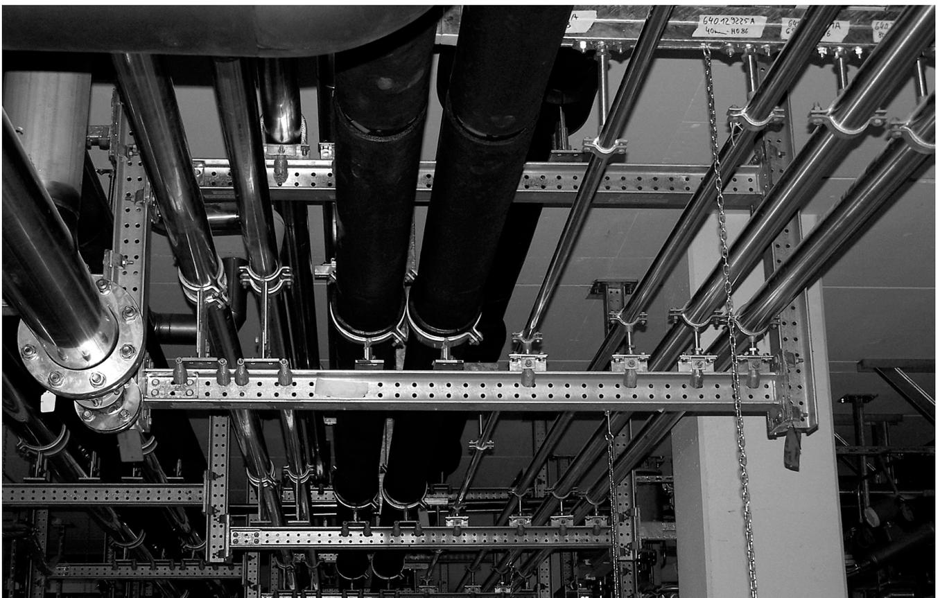
Sonderbauteile: Montage mittels Schweißplatten SPL
