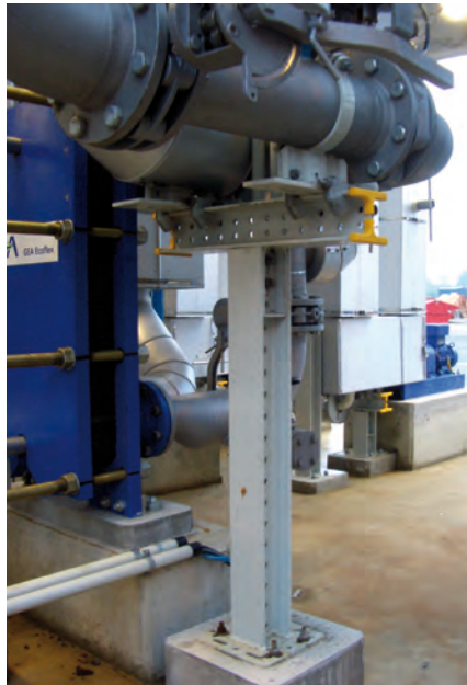
Einsatz des Trägersystems 100 und höhenverstellbarer Lager für den hohen Lastbereich
