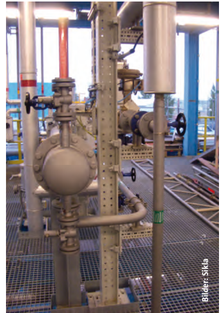
Die Systeme Framo 80 und das Trägersystem 100 lassen sich wirtschaftlich kombinieren
